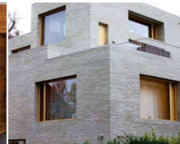
Manufakturfenster in Eiche mit Lüftungsflügel, eingebauter Sicherheit RC2 und Glasüberwachung.
